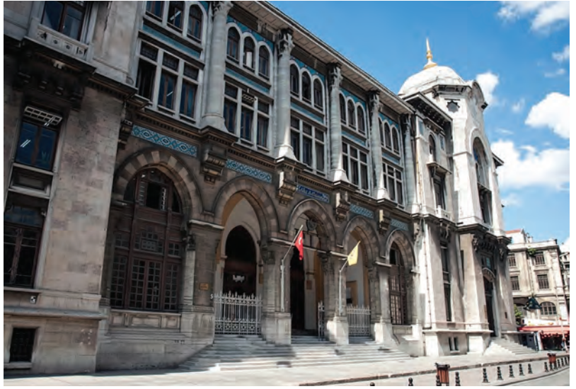
▲ Görsel 3.36: I. Ulusal Mimarlık Akımı'nın ilk örneklerinden olan bu yapıda Batı'nın modern inşaat teknikleriyle geleneksel Selçuklu ve Osmanlı mimari unsurları bir araya getirilmiştir. Büyük Postane, İstanbul
