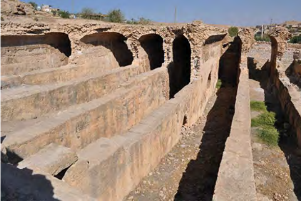
▲ Mardin'e bağlı Oğuz köyündeki Dara Antik Kenti'nde bulunan ve yağmur sularını hem açık hem kapalı alanda depolamak amacıyla yapılan su sarnıcı, VI. yüzyıl
