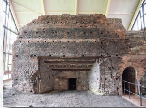
1709'da Abraham Darby'nin kömür yerine kok kullanarak demir erittiği fırın, Coalbrookdale (Kolbrukdel)/ İngiltere
