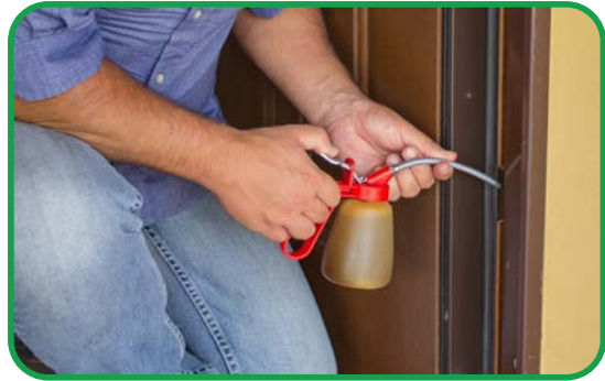
Görsel 2.3.16: Kapı menteşesinin yağlanması
