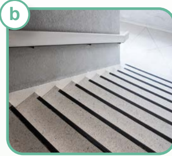
Merdivenlere kaydırmaz bant yapıştırılması
