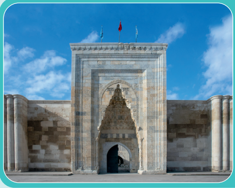
Görsel 1.9: Sultanhanı Kervansarayı
