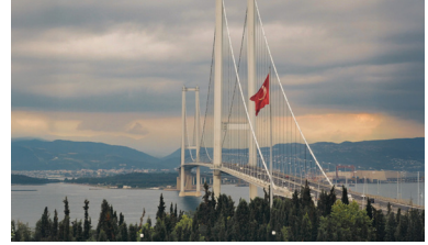
Görsel 3: Osman Gazi Köprüsü
